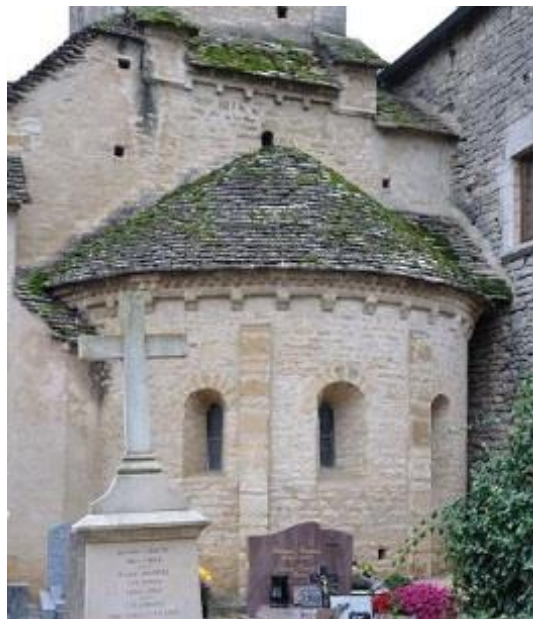
l'abside avec ses 3 fenêtres en plein cintre avec ébrasement
