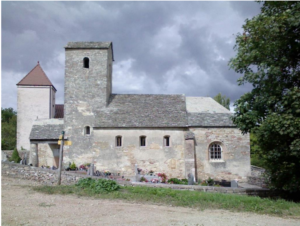
Vue de l'église côté sud, chevet, nef, clocher et auvent
